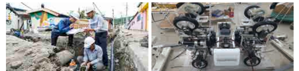
노후관로 개량 공사
